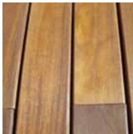
Terrasse traitée avec Cetol WF 771
